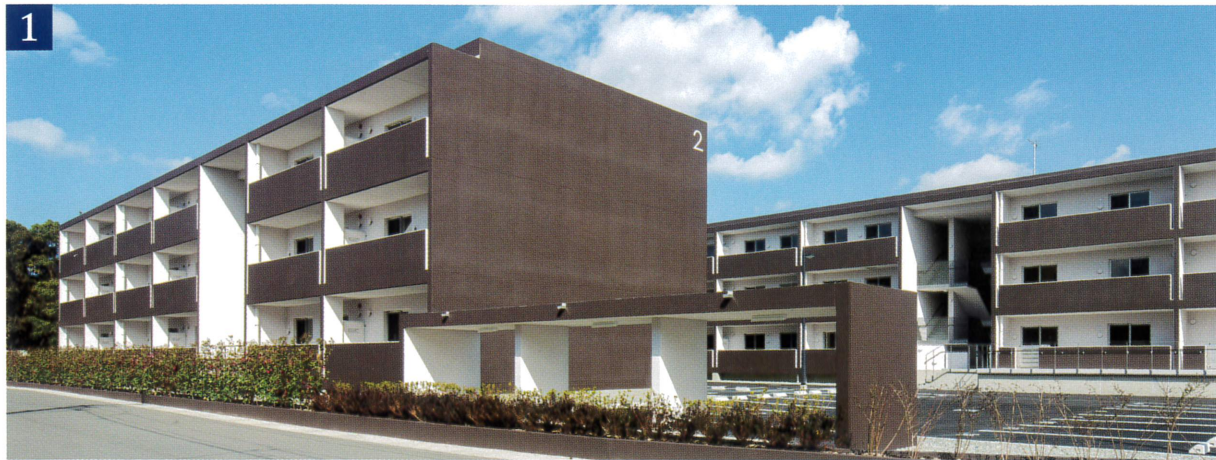
新宮町 緑ヶ浜町営住宅
