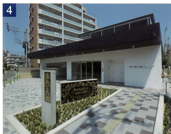
福岡市早良区 高取公民館・老人いこいの家複合施設
